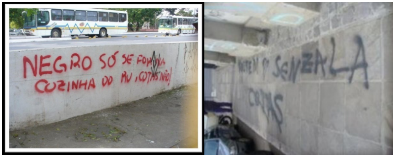
Figura 1. Frases racistas pichadas em prédios da UFRGS em 2007 na véspera da aprovação do sistema de cotas raciais na graduação
